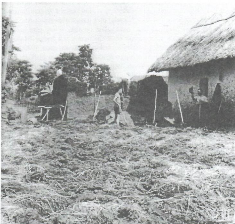
Stavba domu technikou vykladania (cápanje múry) u Slovákov v Maďarsku
