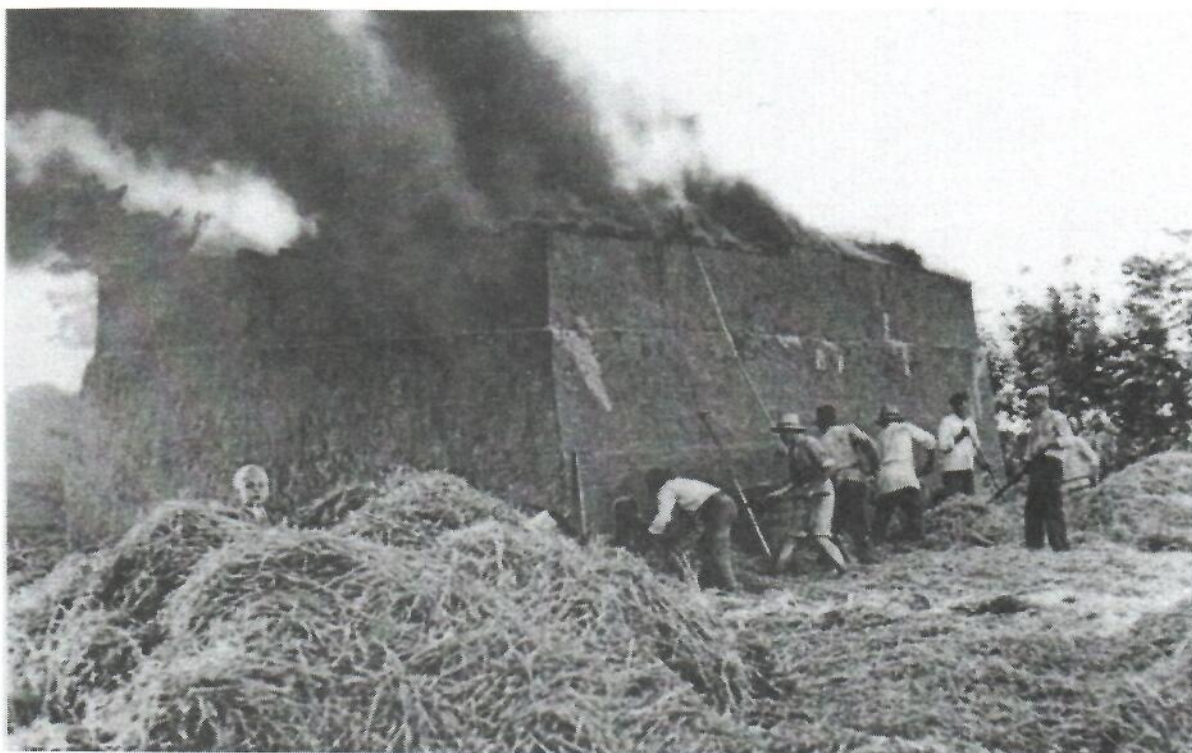
Pálenie tehál na stavbu kostola (Gorna Mitropolija, 1939)
